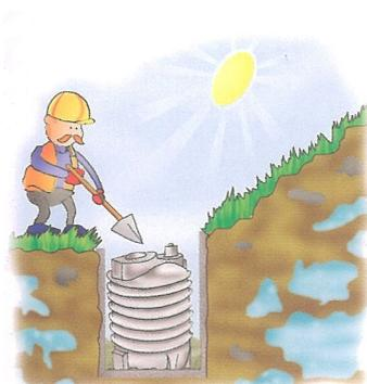
Der Schacht mit einer maximalen Höhe von 50 cm bedecken. Der Schacht wie die benachbarte Zone von diesem sind nicht befahrbar. Vermeiden betonierte Montagen zu realisieren, die während der Unterhaltungen oder des Ersatzes nachteilig sein werden. Die Rohrnetze, andere Zubehörteile und jedes Stück anderes als im anwesenden PE werden an gepumpte Flüssigkeit angepasst sein sollen.
